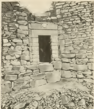
FIG. 448. — LA PORTE ORIENTALE DE KASR-IBRÏM. (Cliché Oropesa.)
